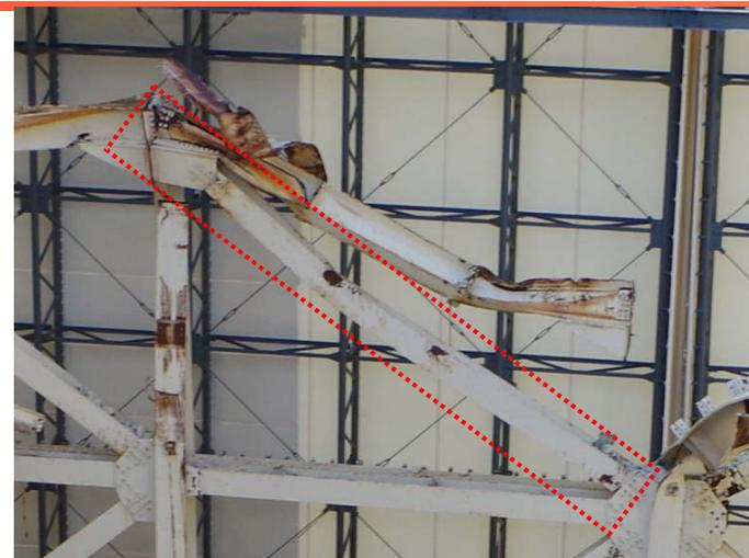
④ 9a-8a通り間上部鉄骨損傷
