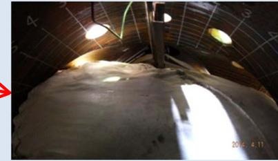
ベント管上部の隙間が大きいため、副閉止補助材の設置をすることとした。
