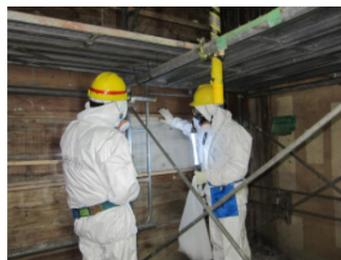
2階における使用済燃料プール底部に設置した支持構造物による補強の状況を確認しました。
