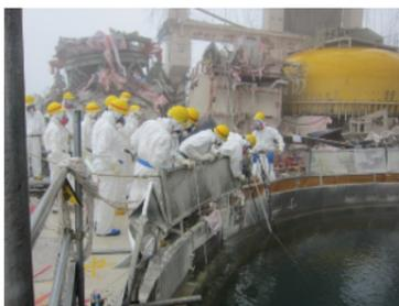
5階において原子炉ウェル水面と床面の水平度を測定する方法を確認しました。
