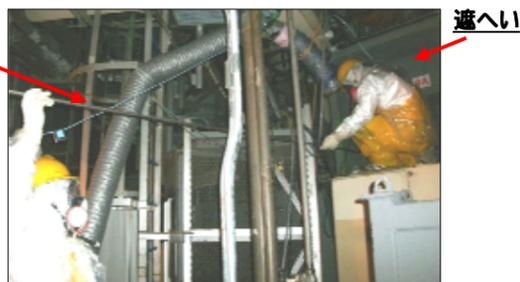
図1：2号機格納容器温度計設置の様子
